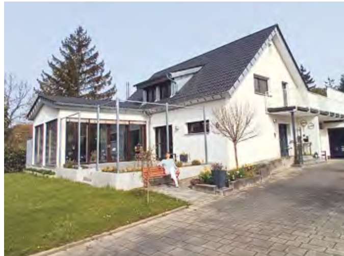
... entstand ein großer, dreifachverglaster Anbau. Das Haus wurde rundum gedämmt.
