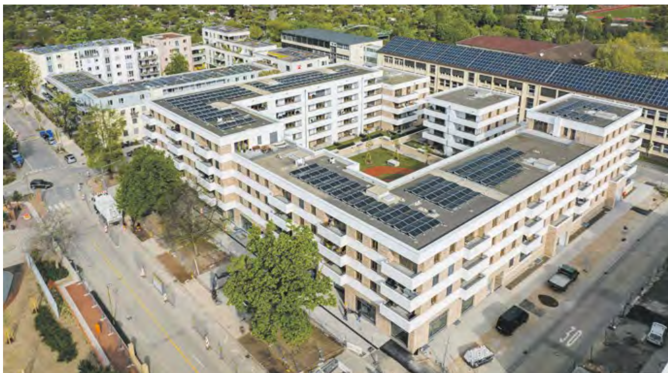
Im Jahr 2021 ging das bisher größte Mieterstrom-Projekt der Stadtwerke Heidelberg Energie im Mark-Twain-Village, Heidelberg-Südstadt, im Auftrag der MTV Bauen und Wohnen ans Netz.
